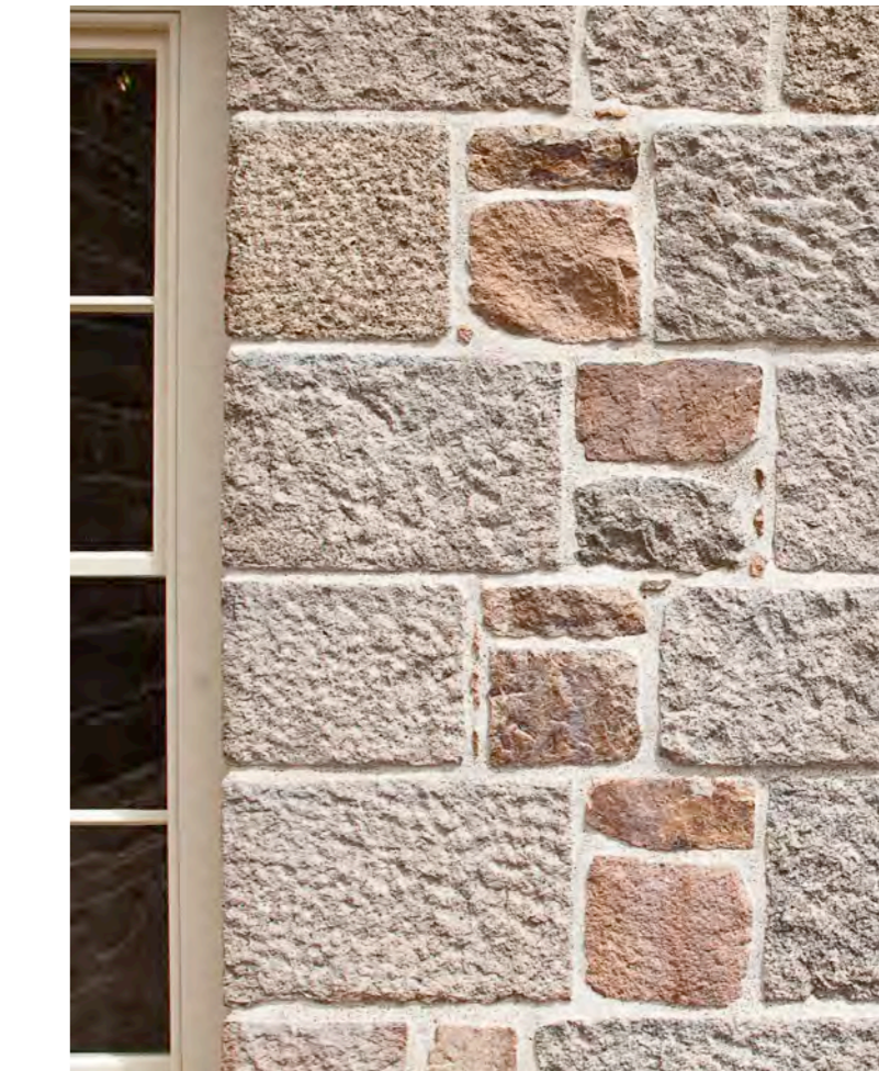
La Valeuse House (1766)
